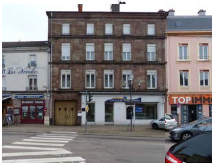
La façade du bâtiment aujourd'hui
